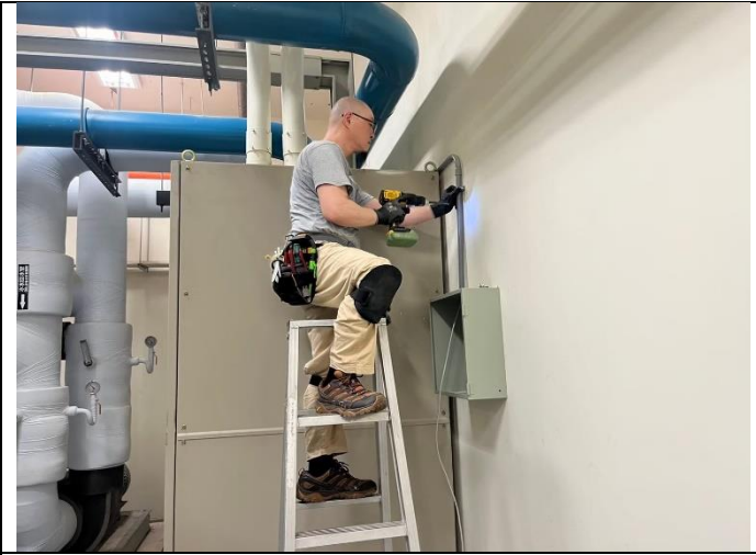
冰水主機控制盤施工中
