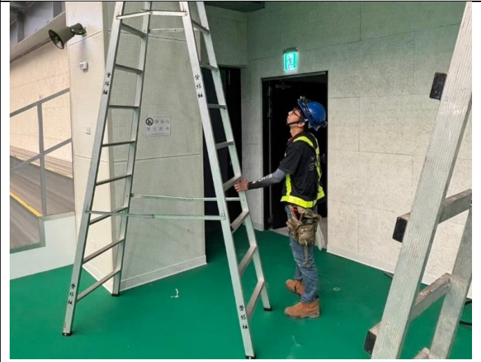
網路開道器施工中
