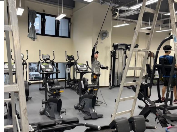
教室加裝冷氣控制系統施工中
