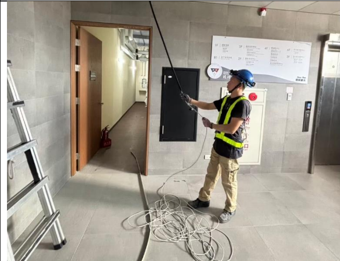
網路開道器施工中
