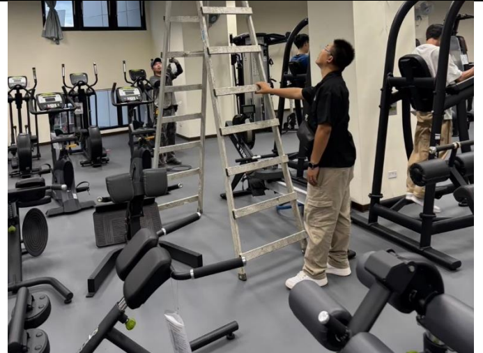
教室加裝冷氣控制系統施工中
