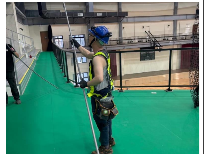
智慧電錶施工中
